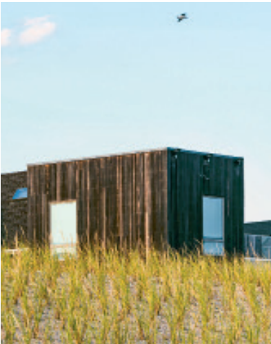
ZEELUCHT De gevels van huizen in de buurt van het strand worden behandeld tegen de werking van de zoute zeelucht.
