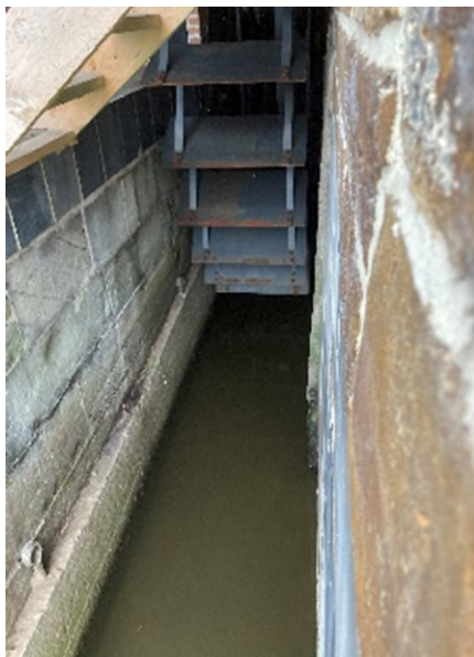
Figuur 5 Onderslagrad watermolen Herkenrode. Foto Willy Vandael.
