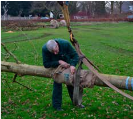
Boom in plantgat zetten met behulp van hijsband en strop
