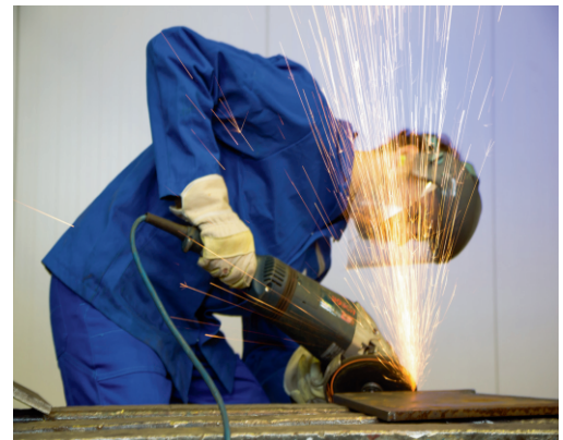
F150: Vonken bij slijpen kunnen brand of explosie veroorzaken.
