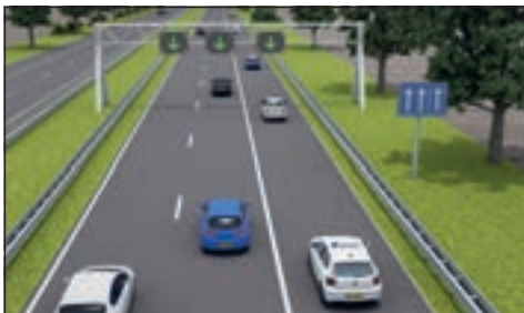
Alle stroken zijn geopend. Dit is te zien aan de groene pijlen boven de rijstroken en het bord naast de weg.
