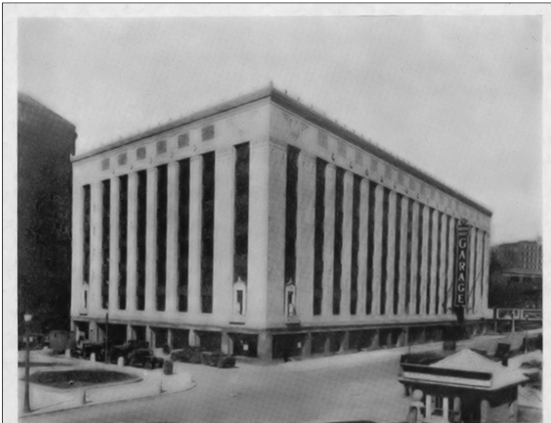
Foto Underwood & Underwood. „Motor Mart”, de grootste garage [ter wereld, is thans te Boston in bedrijf gesteld. Het gebouw is 8 verdiepingen hoog en heeft per verdieping een garageruimte van 5900 M. 2 In totaal kan het (voor onze begrippen nog niet te bevatten) aantal van tweeduizend vijfhonderd automobielen gestald worden l.....
