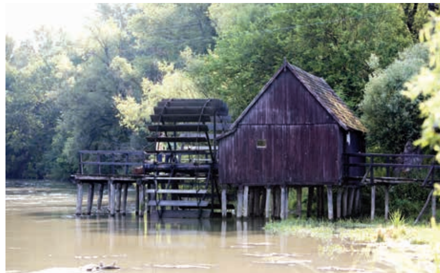
De rustiek gelegen, mooi gerenoveerde watermolen in Tomášikovo.
