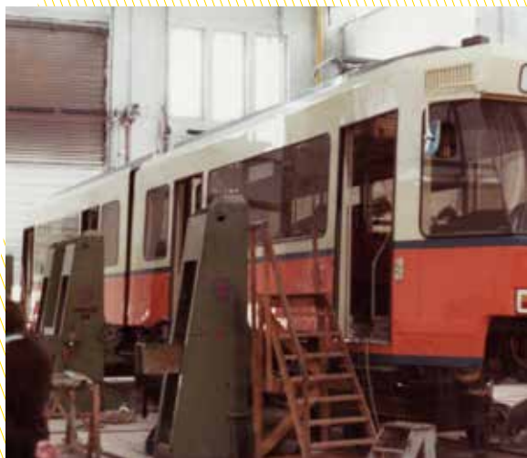
De bouw van de 6000. 20 mei 1980. Foto Pierre de Meyer.
