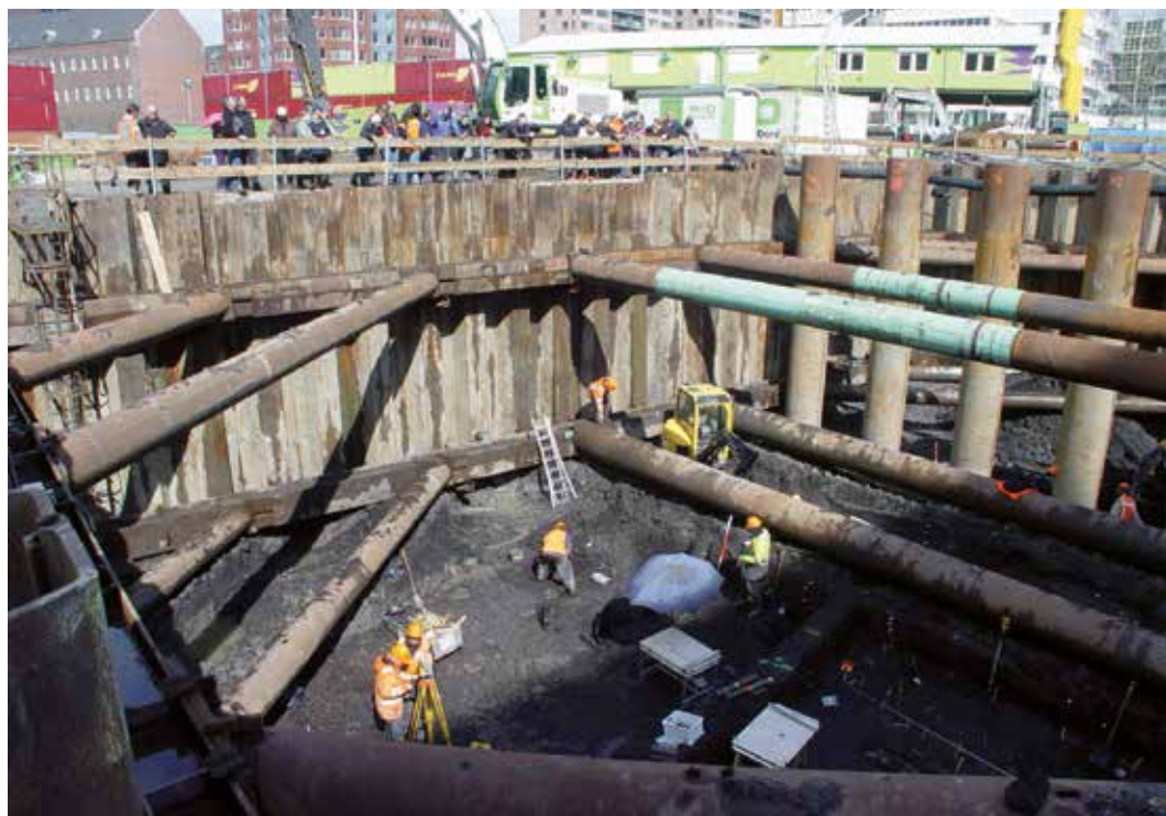
Afb. 1 Opgraving door de archeologen van Rotterdam voorafgaand aan de bouw van de Markthal.
