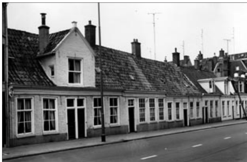
Afb. 11 Kattenhage westzijde. Foto uit 1967. De verzakkingen ter plekke van de voormalige stadsgrachten zijn (nu nog) goed te zien.
