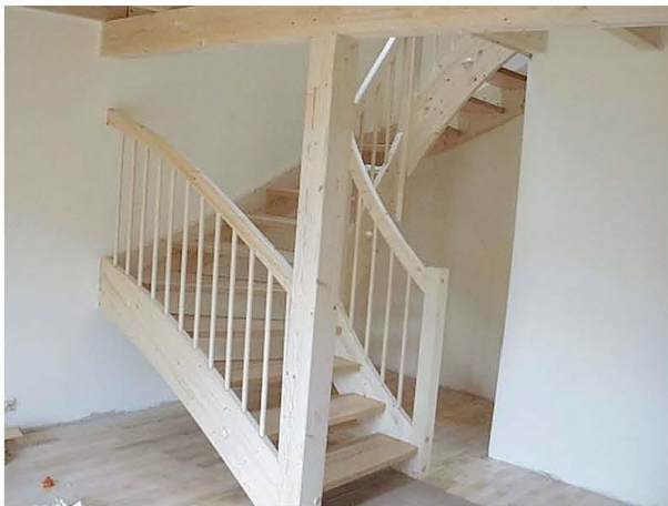
Samengeperst beukenhout wordt o.a. gebruikt voor deuren, maar door de grote buigzaamheid is het ook een van de meest geschikte houtsoorten voor trappen
