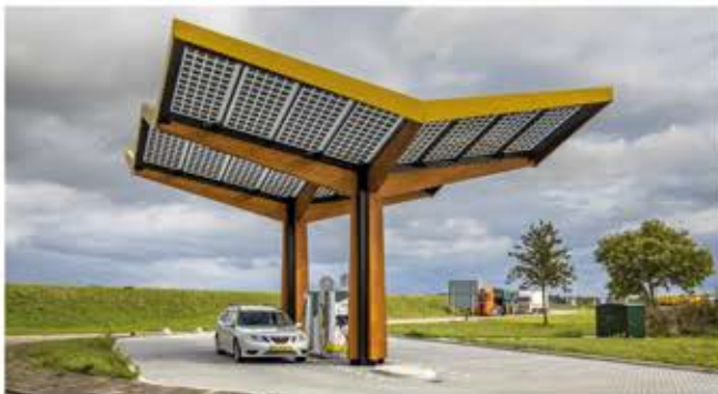
De laadpaal krijgt zijn stroom van de zonnepanelen op het dak.
