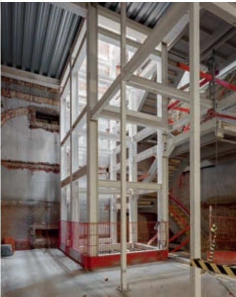
Staalconstructie van een van de vides.
