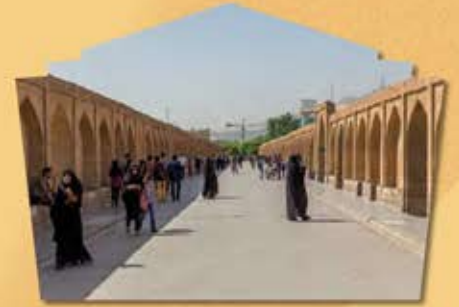
Het brugdek draagt een levende last: alle voetgangers die erop lopen.
