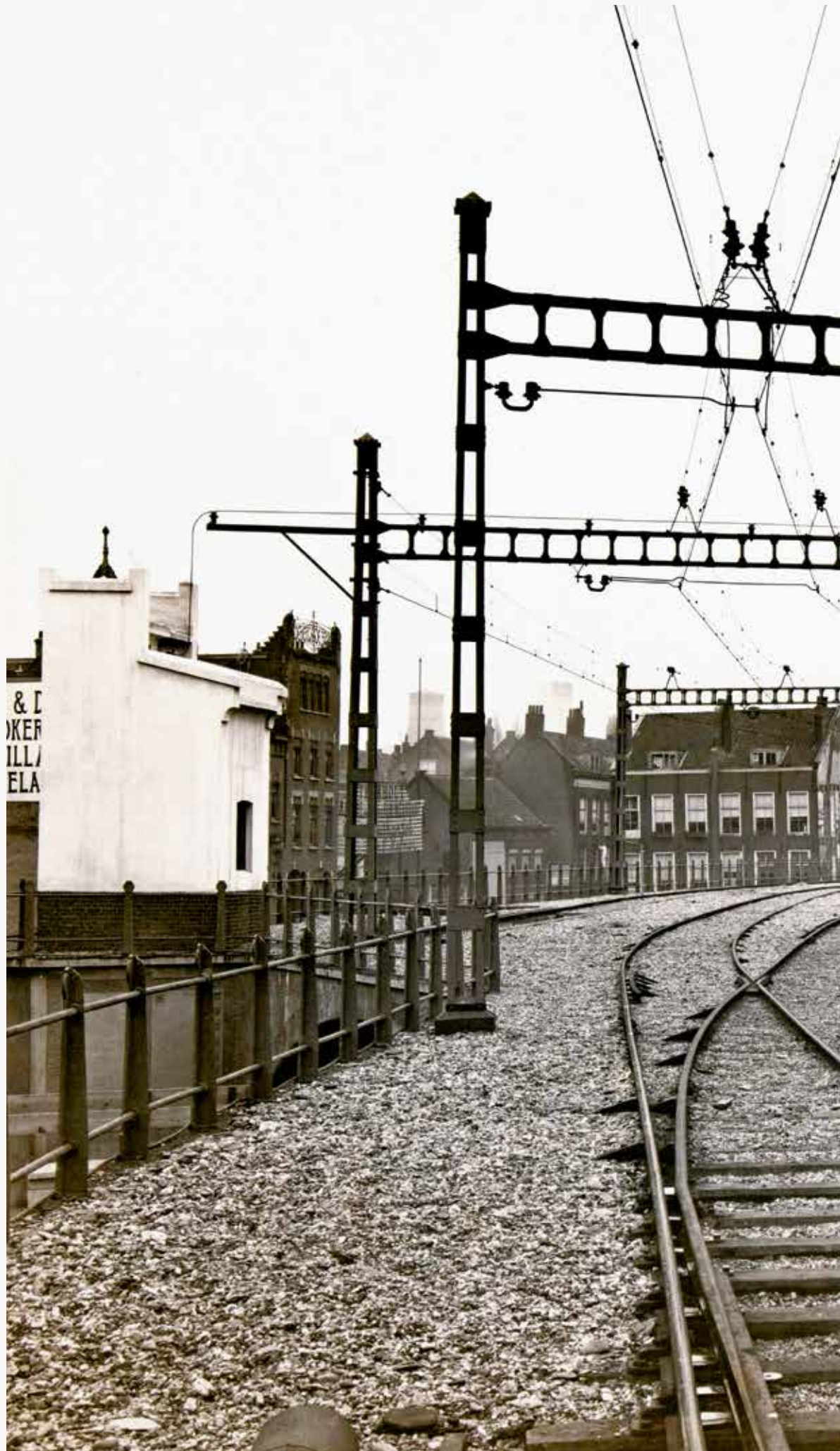
Deze foto uit 1908 van het emplacement van station Rotterdam Hofplein ter hoogte van km 0,3 geeft naast een fraaie blik op de overkapte perrons, ook een goed beeld van de gebruikte bovenleidingconstructie. Rechts aan een bovenleidingmast is een koolspitsbooglamp bevestigd. De booglamp was de eerste vorm van verlichting die werkte op elektriciteit en was vooral geschikt voor de verlichting van straten en terreinen buitenshuis. Links het witte hoogspanningsgebouwtje met de apparatuur voor de beveiliging tegen blikseminslag. Deze foto maakt ook duidelijk hoe het station staat ingeklemd tussen de bestaande bebouwing.
