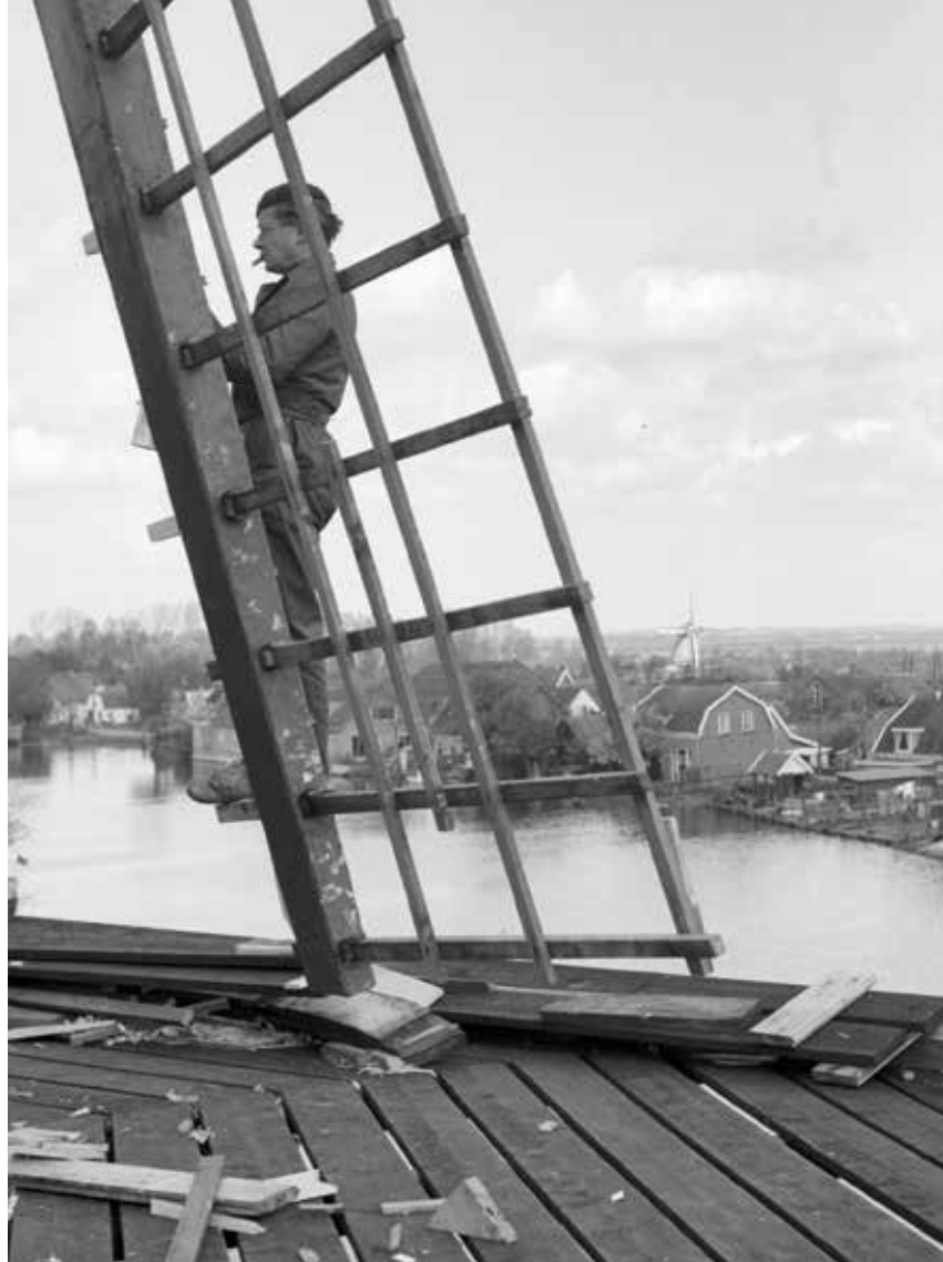
Molenmaker bezig met het wiekenkruis op de stelling van molen De Hoop in Loenen aan de Vecht. (Rijksdienst voor het Cultureel Erfgoed/W.A. Korpershoek, 1964)
