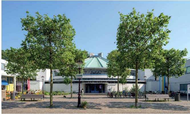
Tolstraat 154-160 Brinkman & Van der Vlugt 1925-1927; 1928-1929
