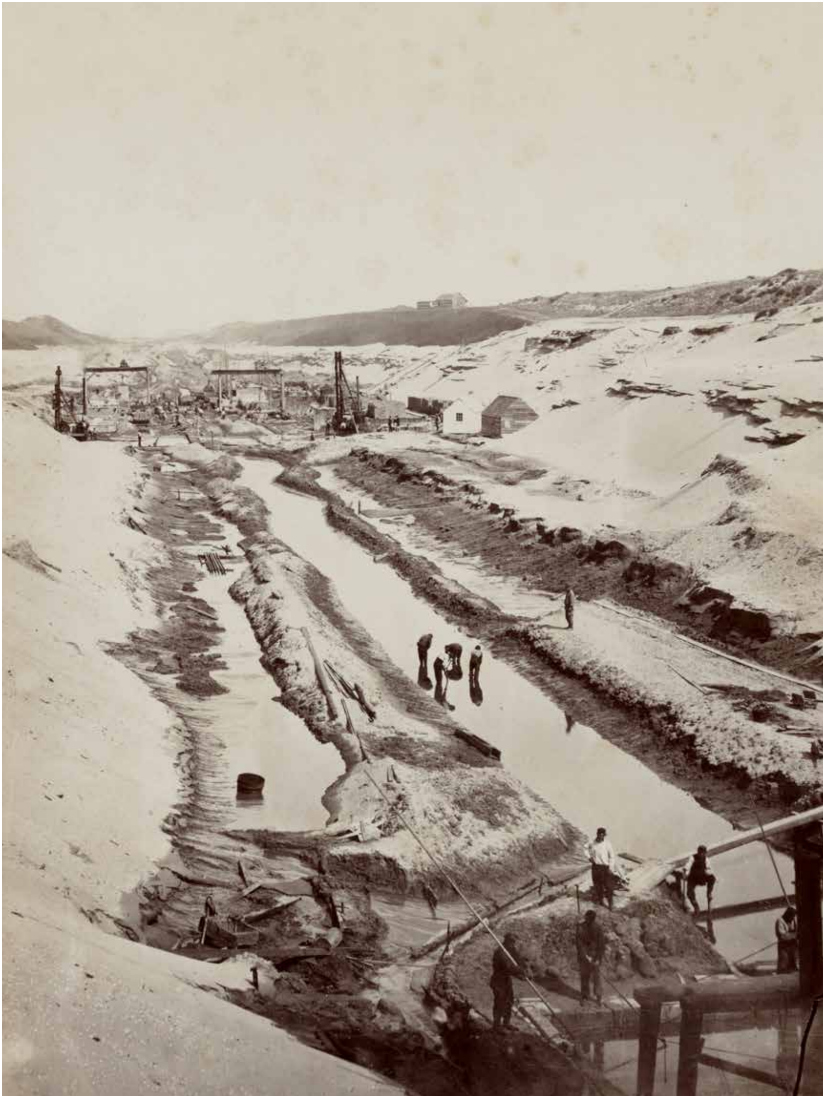
Het uitgraven van de sluisput van de Noordzeesluizen, landinwaarts gezien, omstreeks 1870. Foto: Wegner & Mottu (Nationaal Archief)
