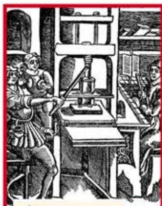
De bouw van een drukpers was gebaseerd op die van druivenpersen.
