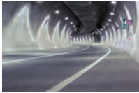
de tunnel tünel
