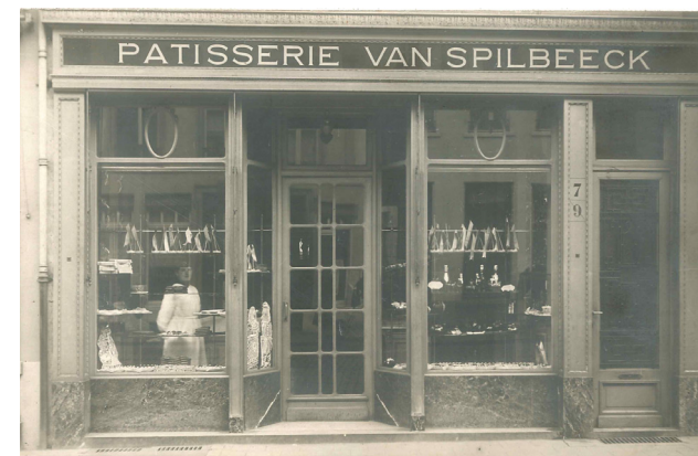
Gevel (na 1923) Façade (après 1923)
