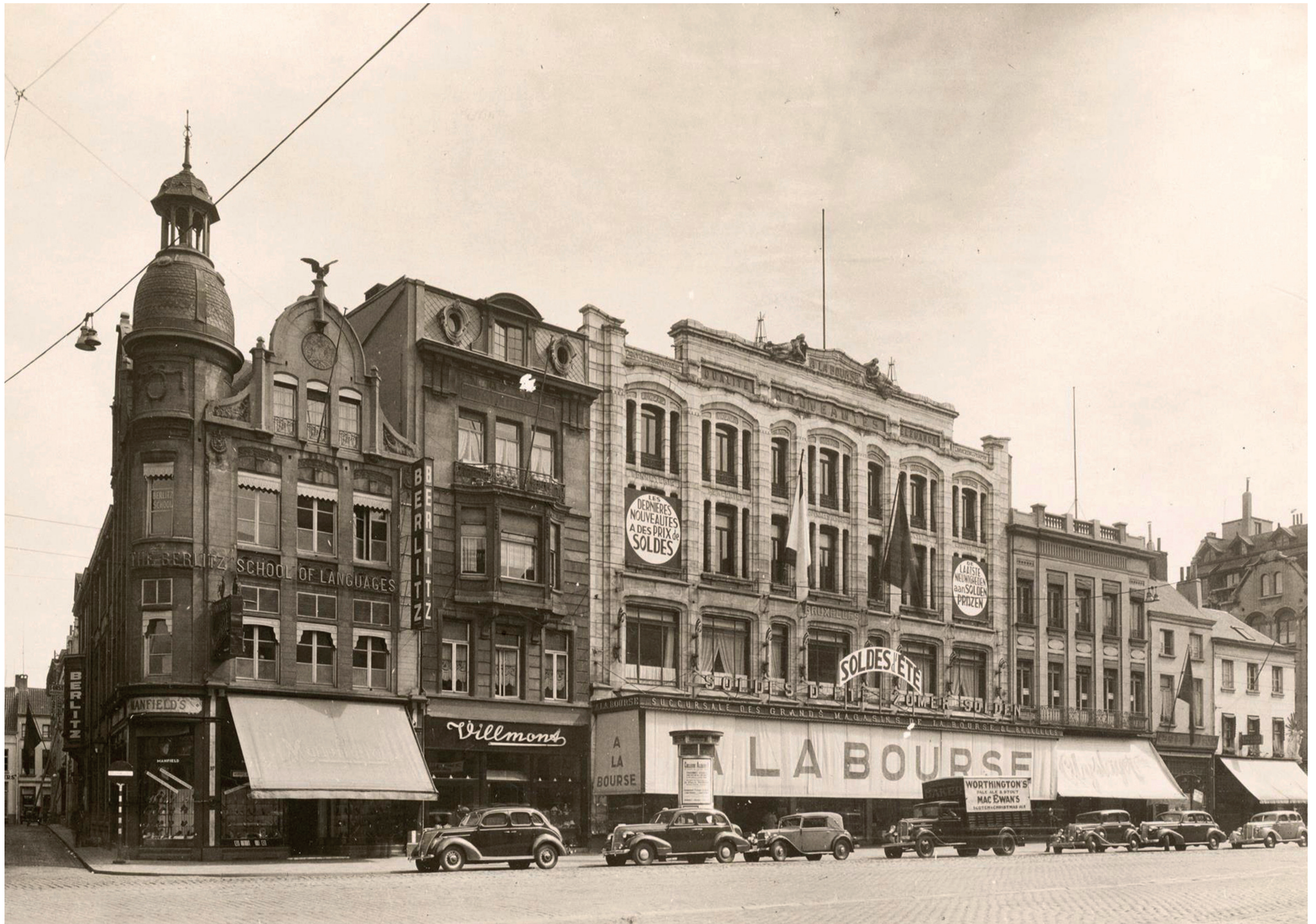
Een eyecatcher op de Meir was het door Horta ontworpen grootwarenhuis op nr. 33 waar tussen 1922 en 1972 Les Grands Magasins La Bourse veel klanten lokte.
