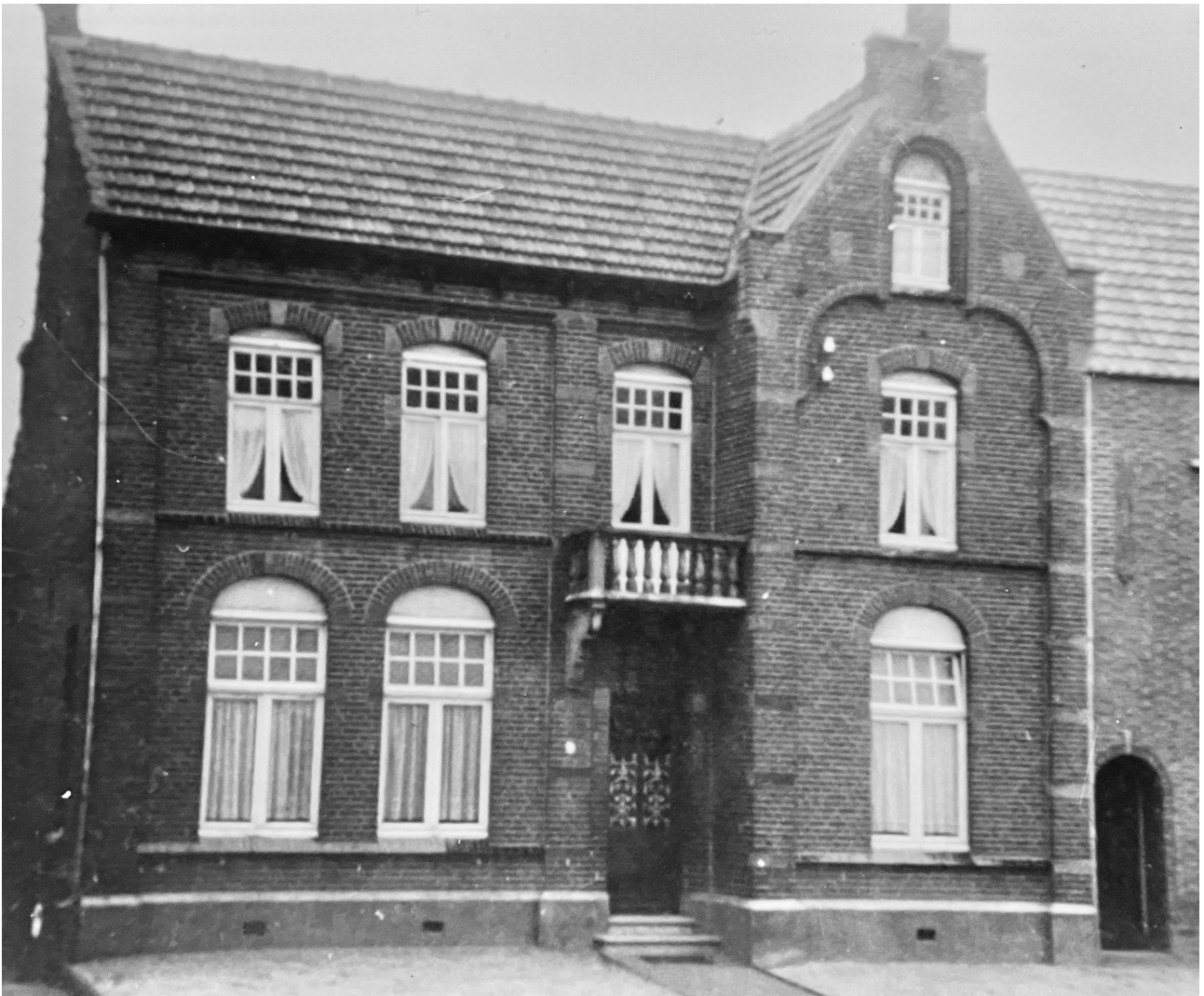
woonhuis en kantoor in de Monseigneur Mannensstraat 5 te Merkelbeek. Rechts naast de voordeur zijn werkkamer en links naast de deur het kantoor
