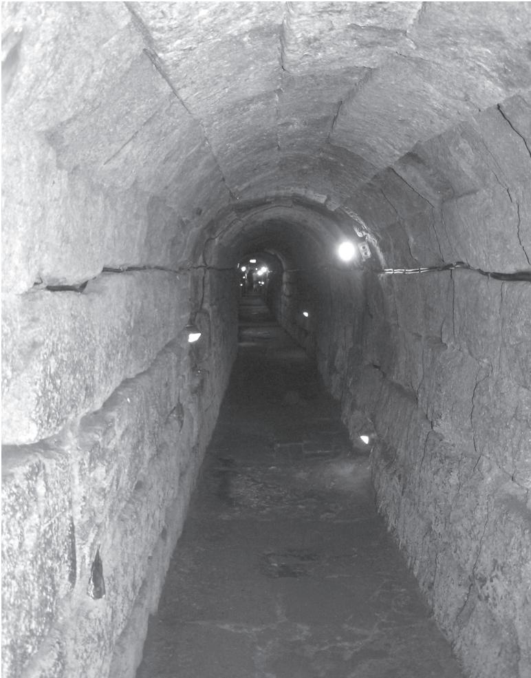
1.1 Het nog steeds toegankelijke stenen Romeinse riool bij het stadhouderspaleis in Keulen, tweede helft eerste eeuw.
