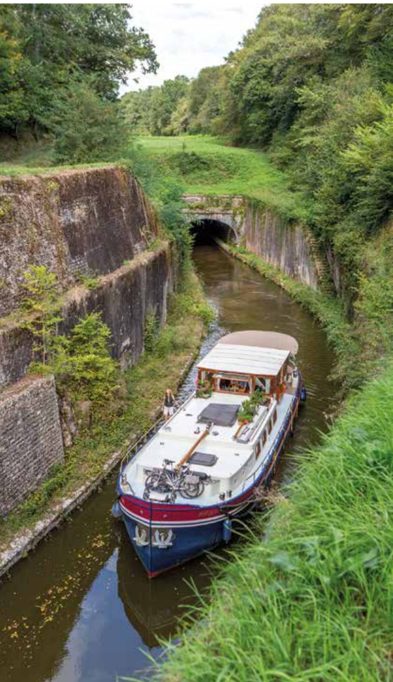
De overwelfde tunnels van La Collancelle, in de omgeving van Corbigny Cr. Guy/hemis.fr
