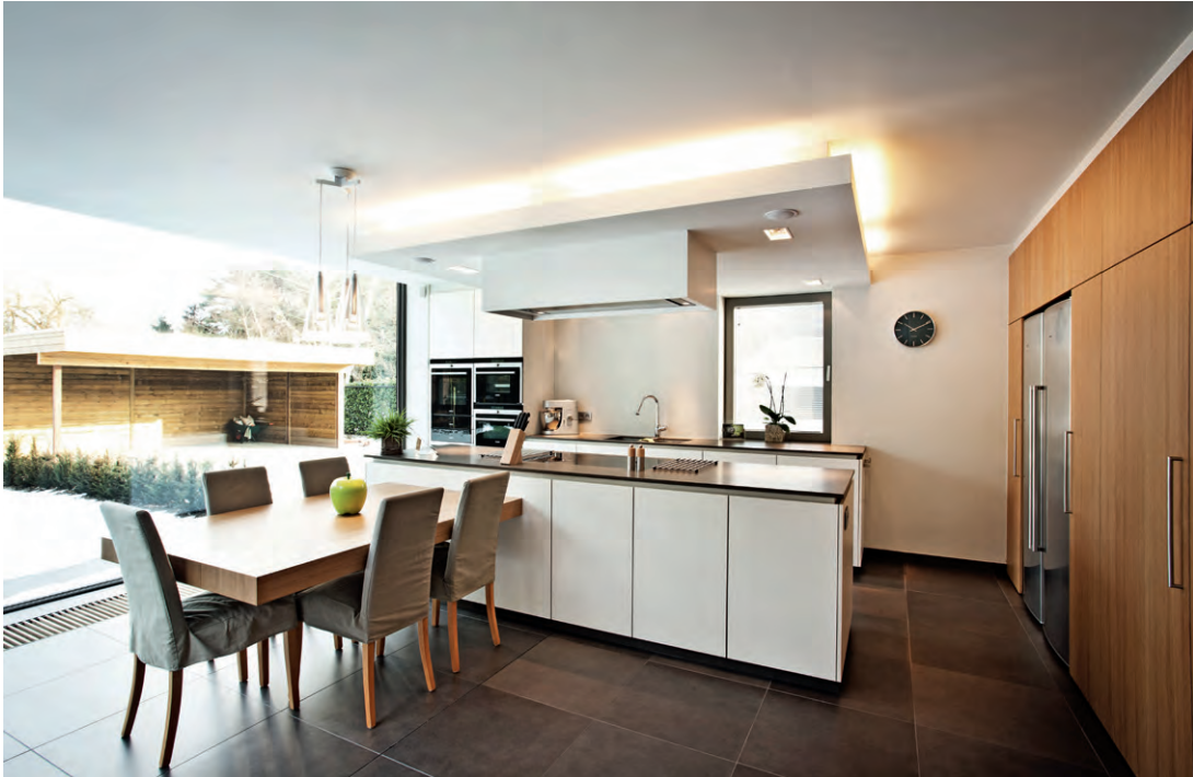
Hier werd een plaatselijk verlaagd plafond gehangen, creatief aangekleed met indirect licht om een lichter effect te verkrijgen en als camouflage voor de dampkapbuis... Een obstakel geeft soms de impuls om het om te buigen naar een leuk accent.
