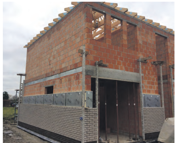
De isolatie en de gevelsteen worden bijna gelijktijdig opgetrokken (ROVE Architecten).
