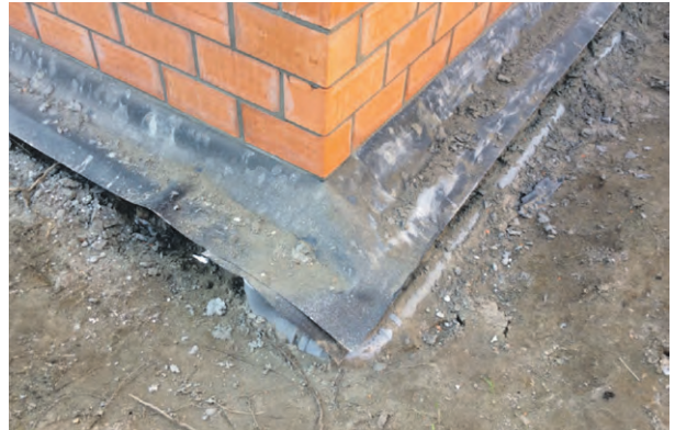
ROVE Architecten: perfect uitgevoerde waterkering
