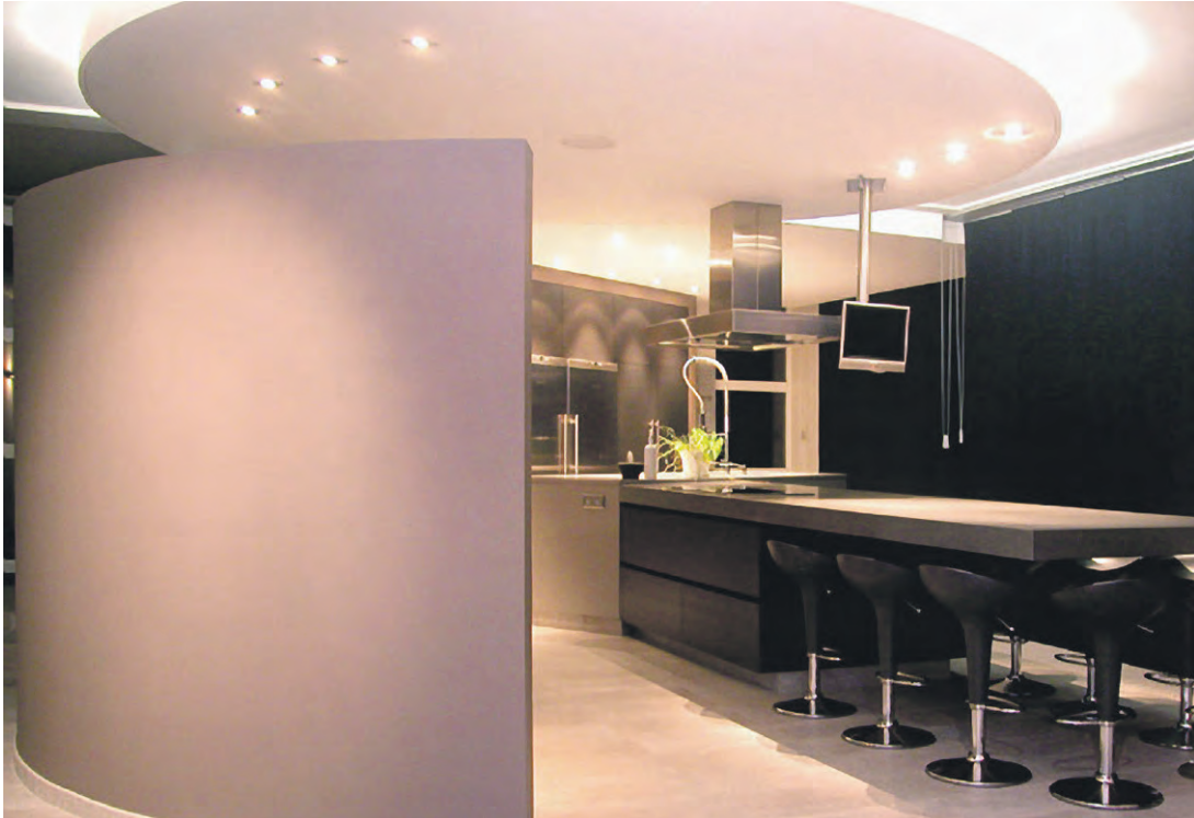
KG-interieurdesign: het ronde verlaagde plafond werd in spanplafond uitgevoerd.
