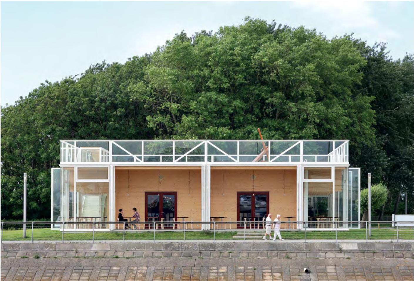
The folding windows are mounted on a rail at roof level. To support this rail, the balustrade—a continuation of the window profiles—is reinforced as a truss, incorporating diagonal braces. | De vouwramen van het schrijnwerk hangen op aan een rail ter hoogte van de dakplaat. Om deze rail te dragen wordt de balustrade – een voortzetting van de gevelprofielen – tot een vakwerk omgevormd door diagonalen toe te voegen.
