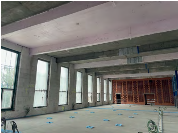
In case of fire, the concrete cover ensures a slower heating of the reinforcement, causing it to lose its strength more slowly. Elements with insufficient concrete cover are treated with intumescent fire-protective paint (pink zones on picture). | Bij brand zorgt de betondekking voor een tragere opwarming van de wapening, waardoor deze haar sterkte minder snel verliest. De elementen met een te kleine betondekking worden behandeld met brandwerende zwelverf (roze zones op de foto).
