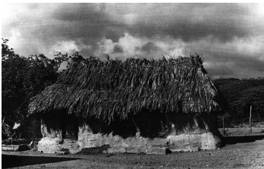
Kas ku dak di pali maishi (dak van maïsstelen): woonhuis van – gemanumitteerde – slaven.
