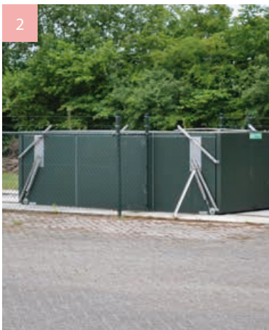
2: Hier worden kadavers aan de weg opgehaald, vanuit een gekoelde opslag. Het bedrijf is verder afgeschermd met hekken.
