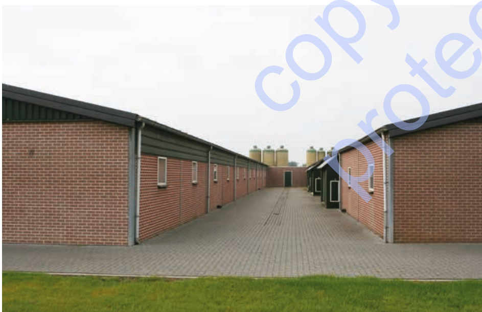
Door de verharding langs de muren durven ratten en muizen niet zomaar dicht bij de stal te komen.
