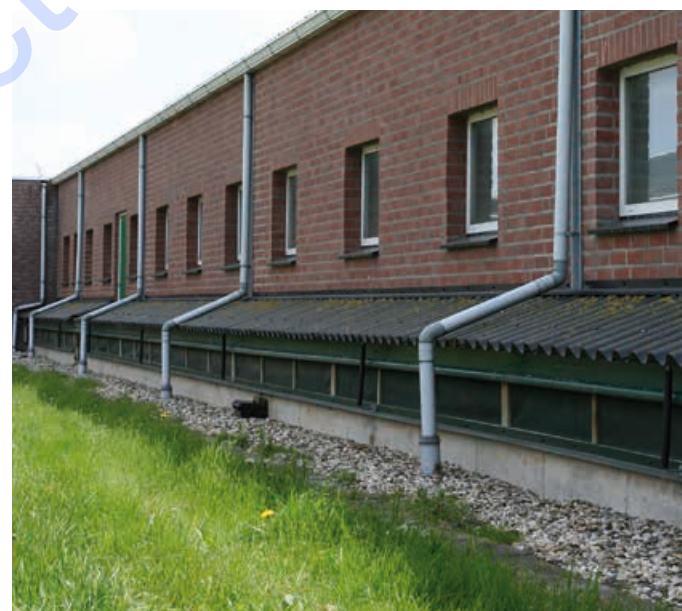
Voor deze luchtinlaat zit fijn gaas dat voorkomt dat vogels en ander ongedierte naar binnen kunnen.
