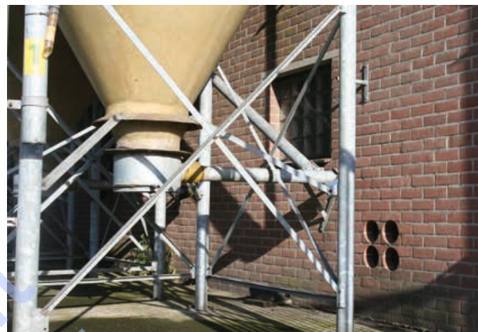
Ongediertebestrijding begint met het goed afsluiten van de stal. Metsel deze gaten dus dicht.
