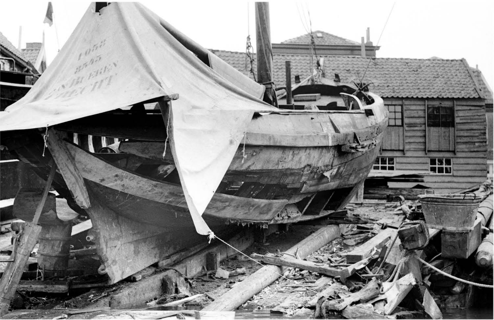
Vernieuwen van de huidgangen in het achterschip
