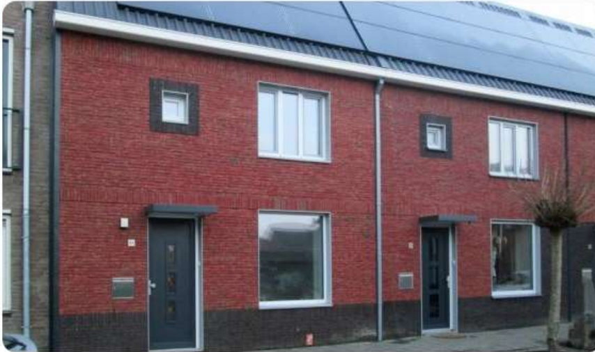
Renovatie, eengezinswoning gebouwd tussen 1950 en 1970 gerenoveerd 2015 naar nul op de meter, hellend dak
