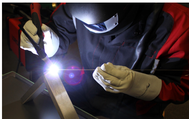
▲ 4. Las eerst de buitenhoek af. Gebruik toevoegmateriaal om de lasnaad op te vullen. De lasstroom bedraagt hier ongeveer 60 ampère.
