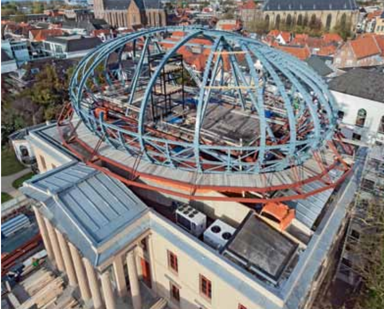
1.9 Uitbreiding museum De Fundatie in Zwolle met een centraalhal op het bestaande gebouw (ovale plattegrond met radiale, gebogen spanten).
