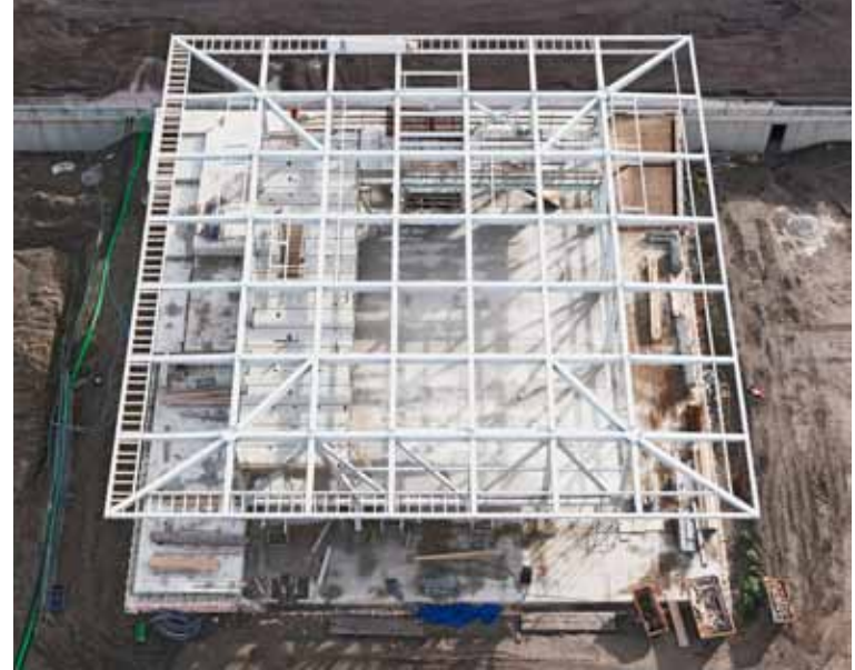
1.10 Erasmus paviljoen in Rotterdam met een centraalhal (vierkante plattegrond met een balkrooster).
