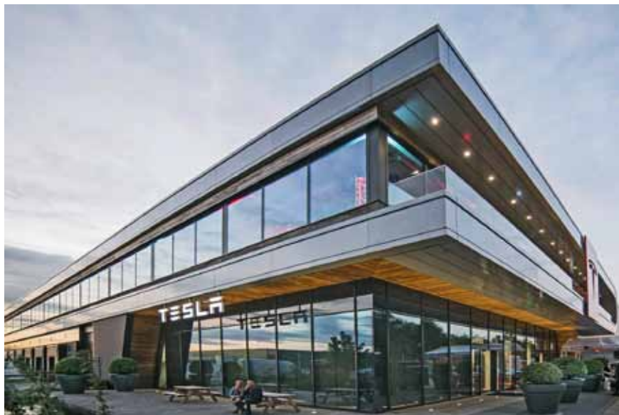
1.79 Tesla-assemblagefabriek (NewLogic II) in Tilburg: hallen met een kantoor.
