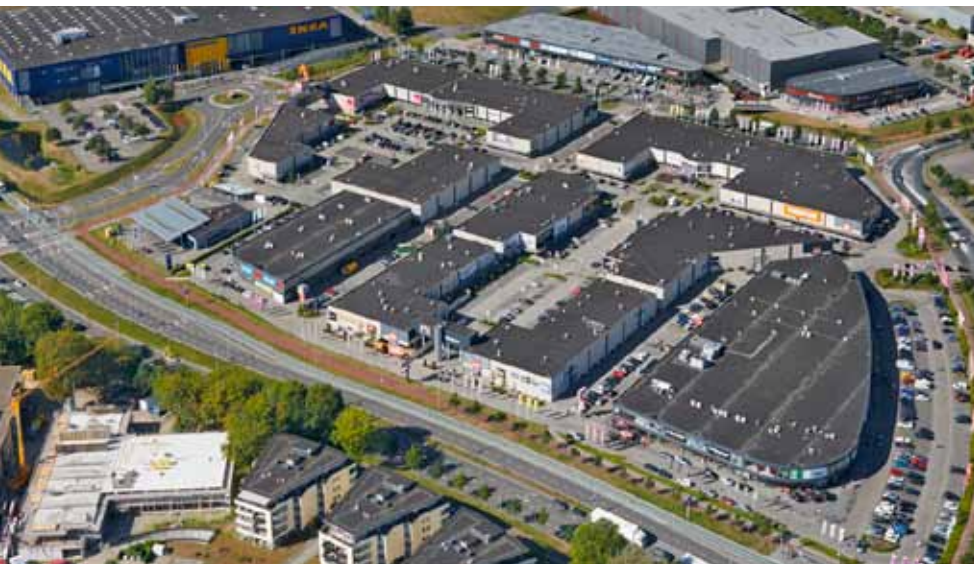
4.1 De meeste industriehallen in Nederland hebben een plat dak.
