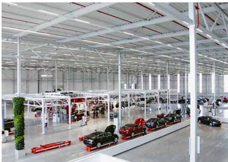
1.80 Tesla-assemblagefabriek (NewLogic II) in Tilburg: de staalconstructie bevat zo min mogelijk kolommen.
