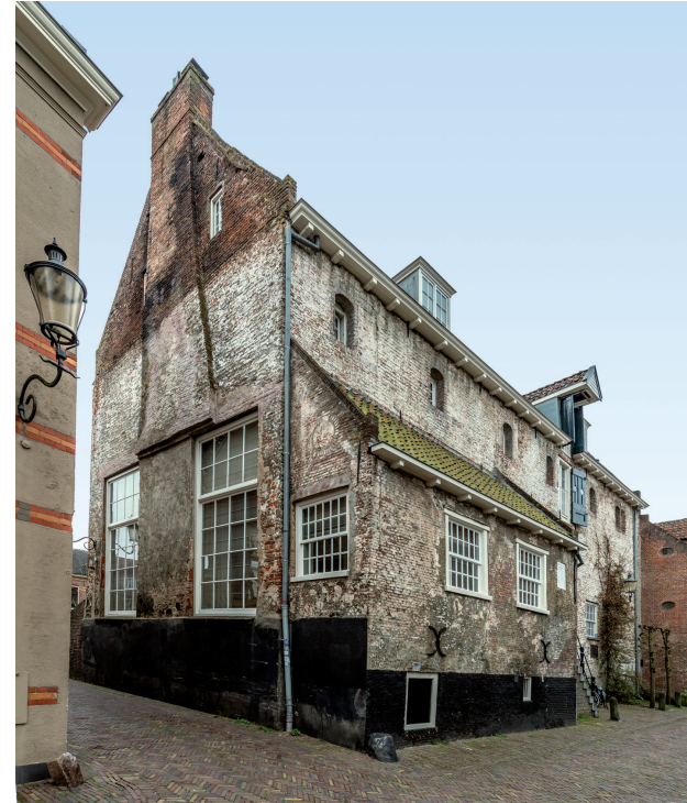
Zicht op de noord- en oostgevel vanaf de Muurhuizen.
