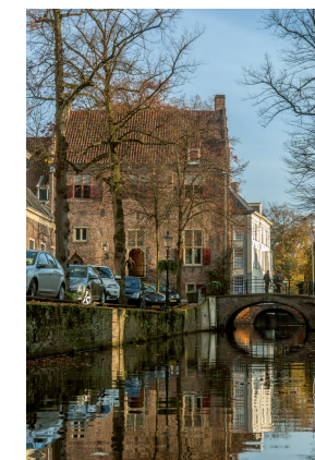
Tinnenburg naast de brug over de Kortegracht. In de voorgevel van het huis zijn de bogen van de weergang van de stadsmuur nog herkenbaar. Aan de andere zijde van de brug stond muurhuis Rommelenburg.
