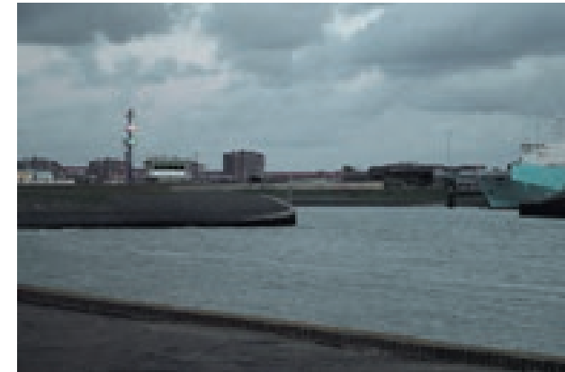
De seinmast ten noorden van de voorhaven.
