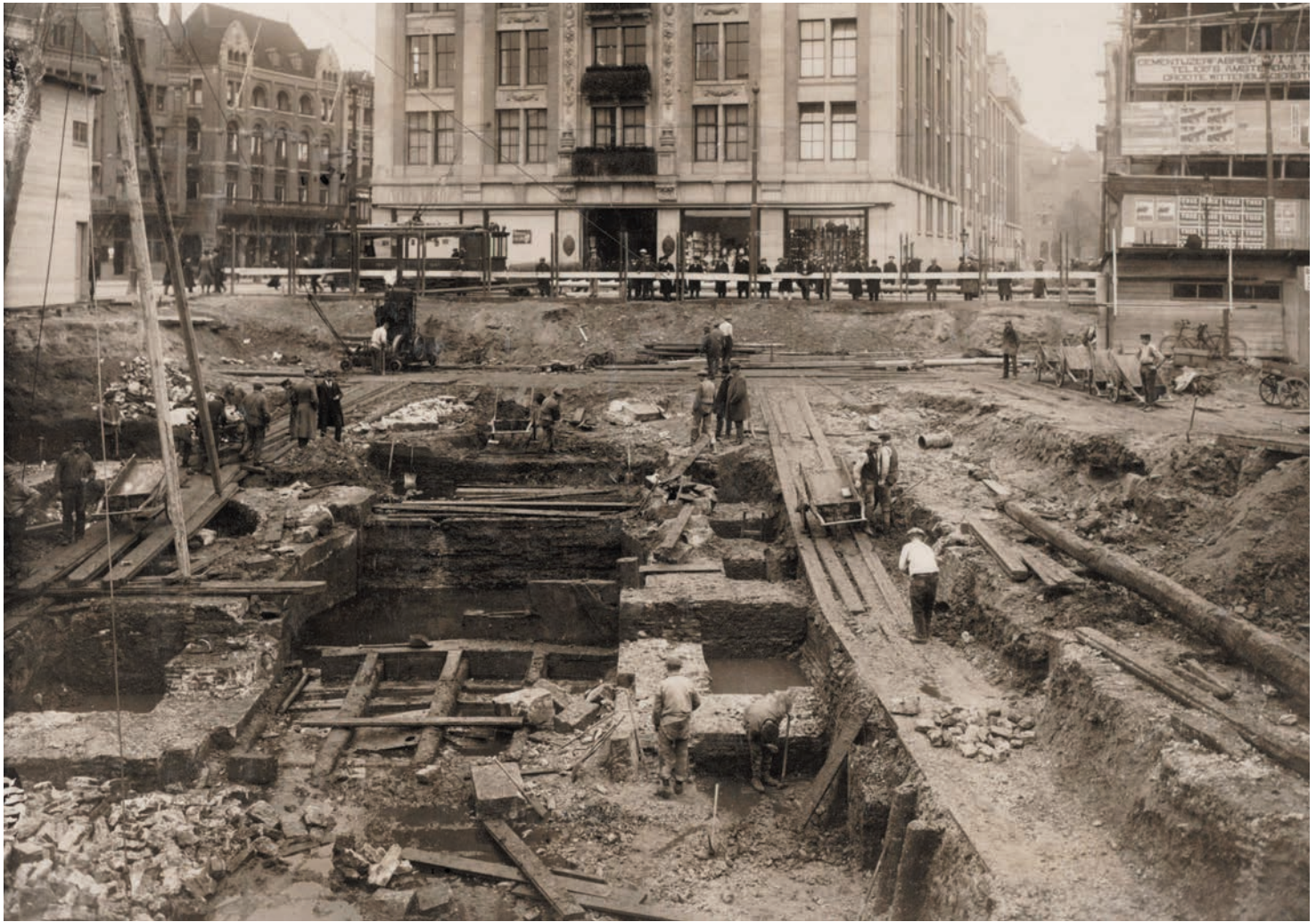
Na de grootschalige sloop aan de Vijgendam stuiten archeologen omstreeks 1915 op het fundament van de oude damsluis.
