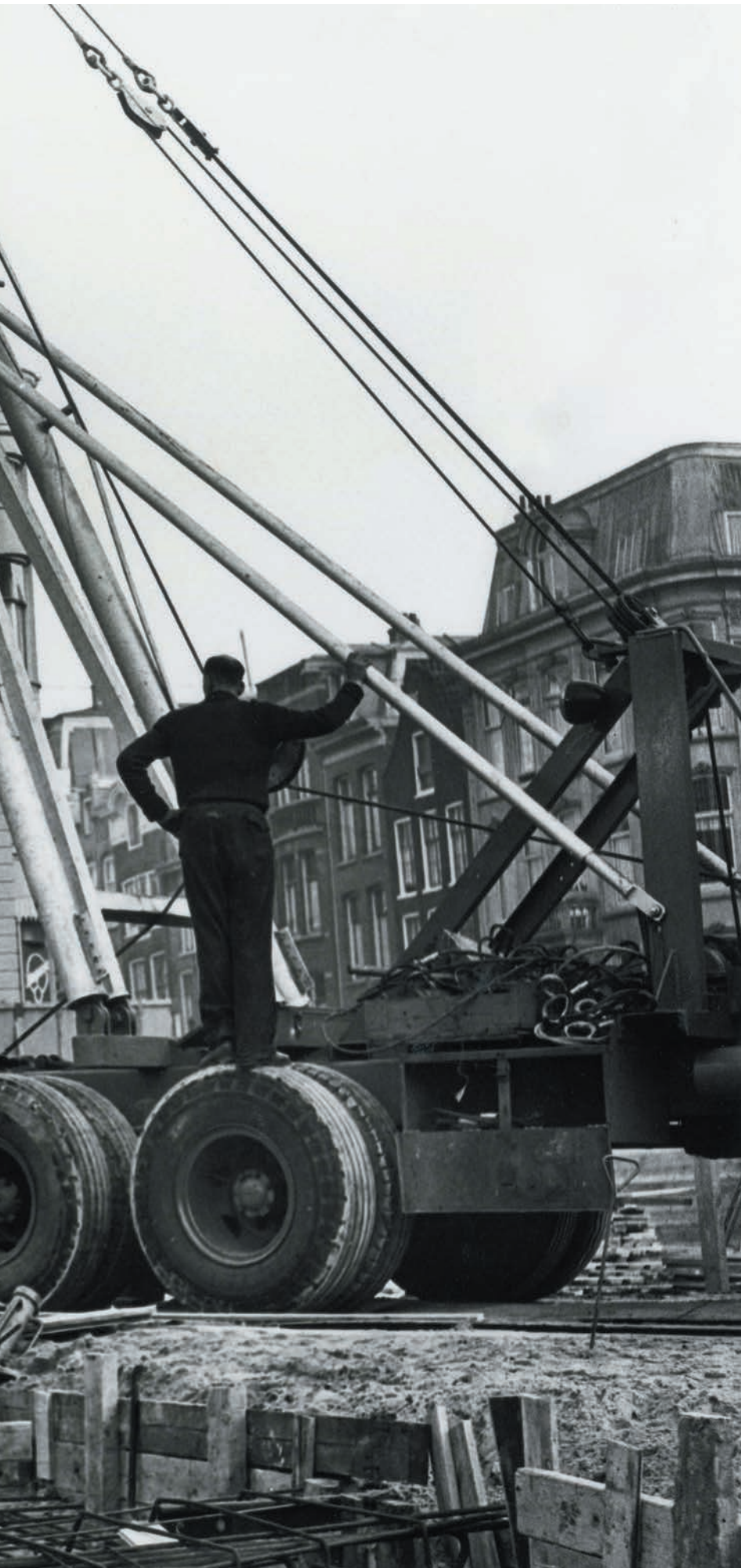
Twee van de vier geketende figuren worden in 1955 op hun plaats gehesen, nog voor de pyloon is afgebouwd.
