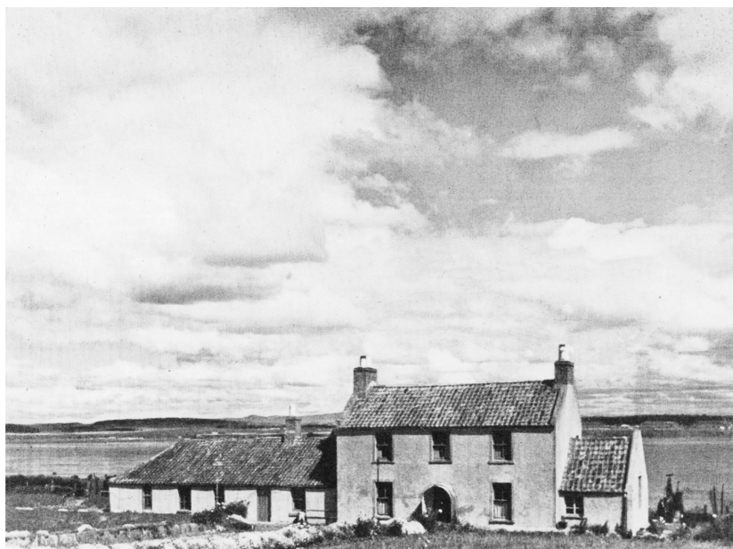
Het huis op Barrandale Island, voor het werd gerenoveerd en geschilderd, circa 1960.
