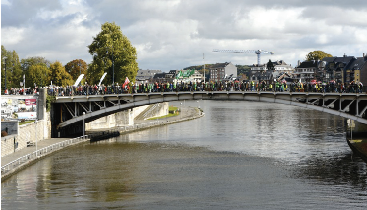
Betoging op de Pont de France, aan de samenvloeiing. Alweer: gebeurt heel zelden.
