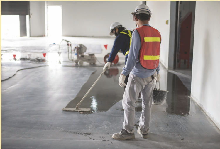
Figuur 6 Het aanbrengen van een vloeistofdichte epoxycoating op de vloer (Bron: Shutterstock / Bannafarsai_Stock)
