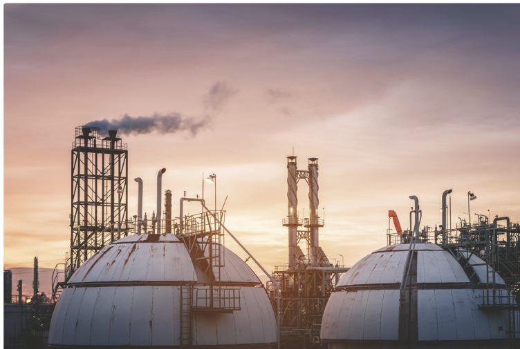
Figuur 9 De hoge schoorsteen van deze raffinaderij zorgt ervoor dat de gassen op grote hoogte worden uitgestoten. Zo slaan ze niet neer op de leefomgeving. (Bron: Shutterstock / manine99)
