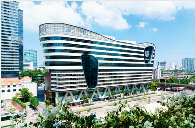
Gebouw van Unilever in Bangkok, Thailand
