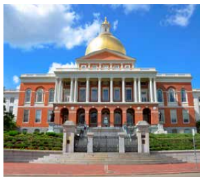
Massachusetts State House met de vergulde koepel, ontworpen door Charles Bulfinch
