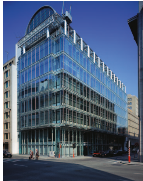
Fig. 2 | 01-225 | Immeuble Brussimmo | Bruxelles | 1989-1993
