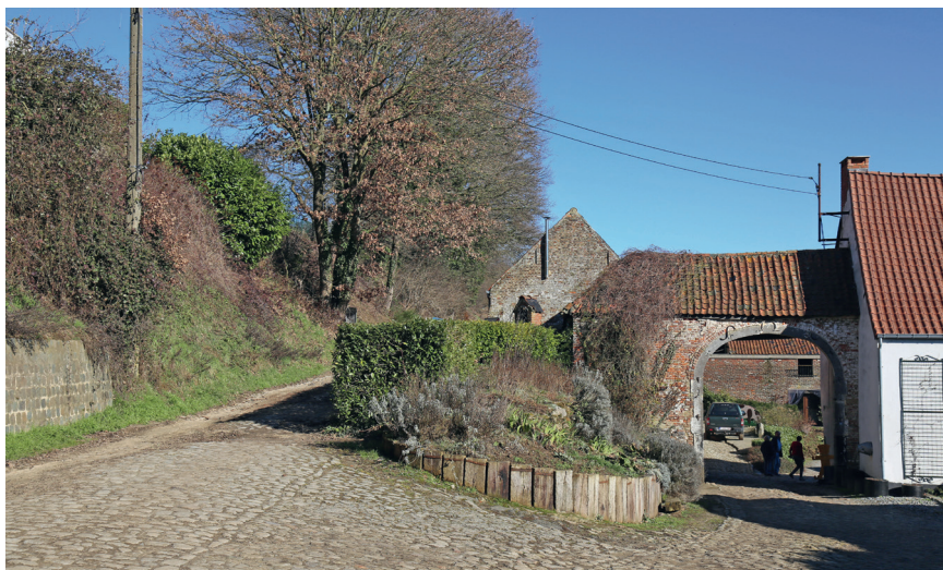
Porche d'entrée de la ferme de Bousval
